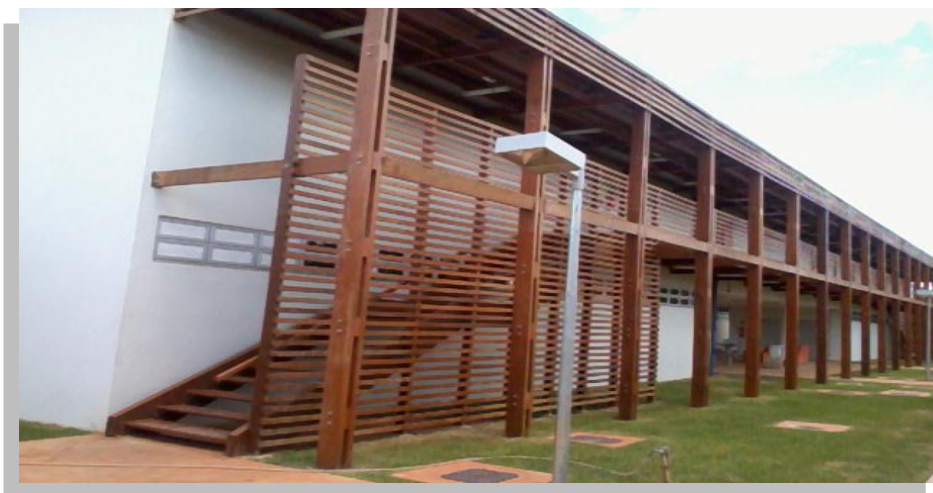
Foto (6). Fachada externa do prédio do alojamento da LEdoC / UnB. (Arquivo pessoal)
