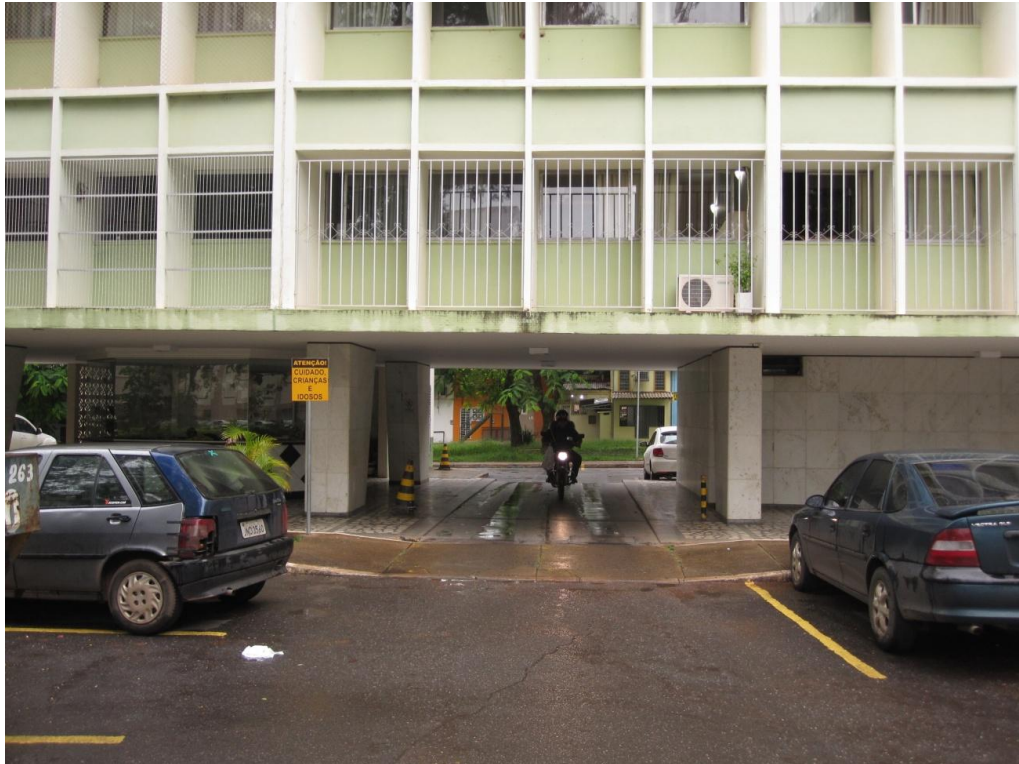
Figura 14: motociclista passa pelos pilotis de um bloco da SQS 107, que transformou a área em passagem para um estacionamento pavimentado construído do outro lado do prédio. Fonte: Foto do autor, 2014.
