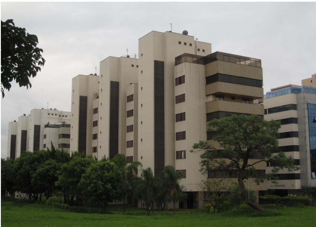
Figura 16: edifício da SQN 110. Percebe-se a desconfiguração do gabarito previsto e a cobertura. Fonte: Foto do autor, 2014.
