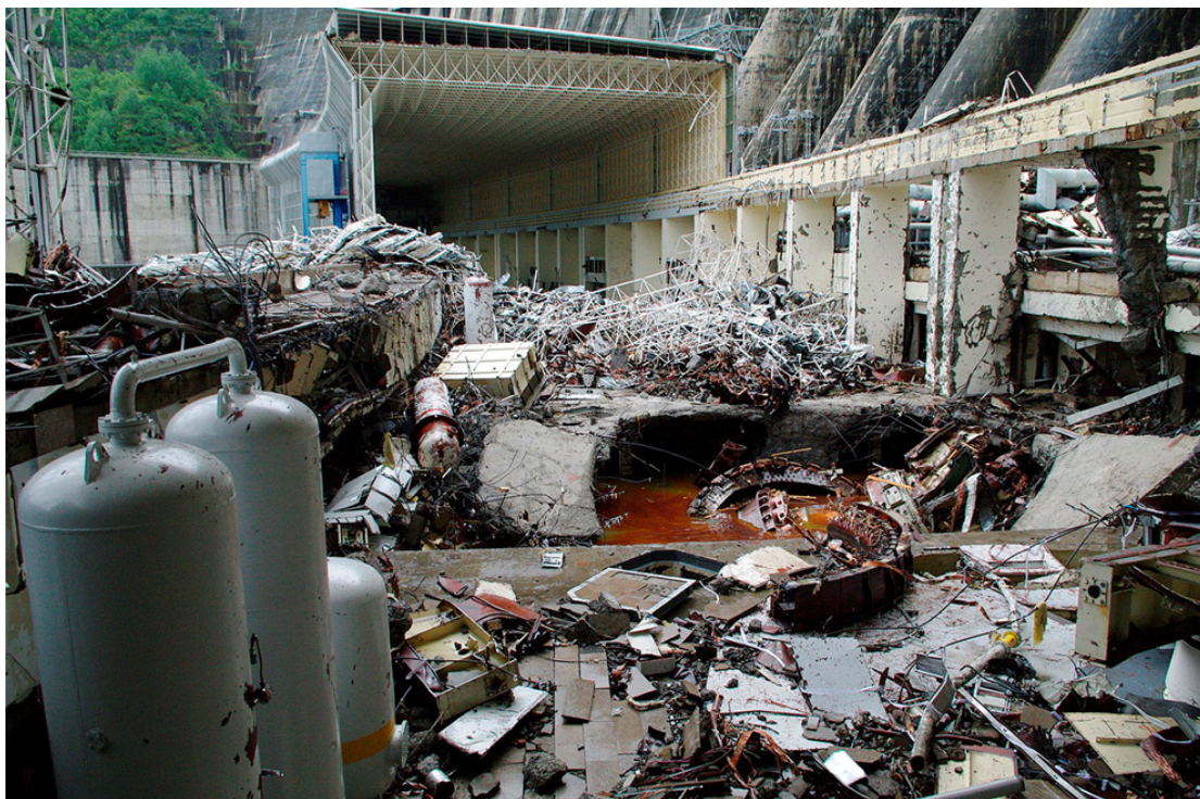
Figura 1 - Usina de Sayano Shushenskaya na Rússia 2009.
