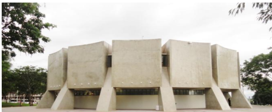
Figura 1: O prédio onde se localiza o Planetário de Brasília.
