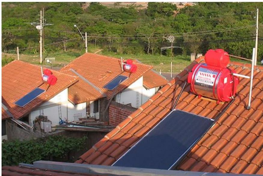
Figura 19: Sistema de aquecimento de água com coletores solares da empresa Heliotek<sup>21</sup>
