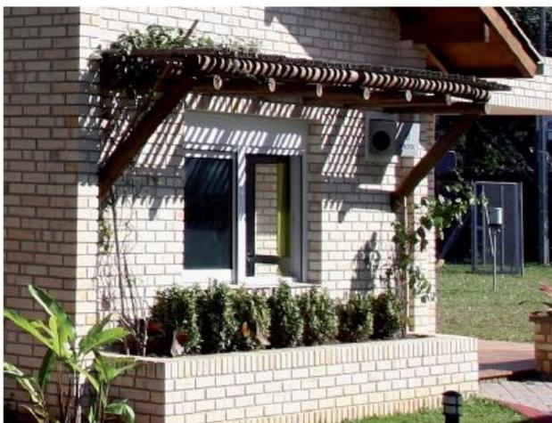
Figura 15: Dispositivo de sombreamento na Casa Eficiente (LabEEE, 2010).
