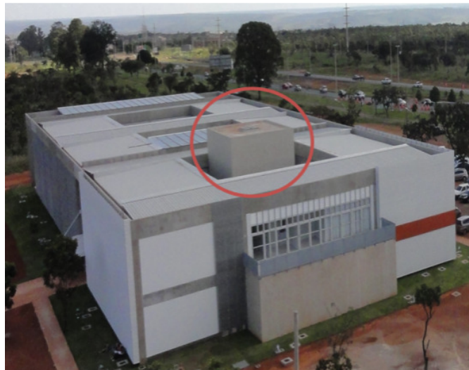
Figura 14 - Local de instalação do aerogerador.
