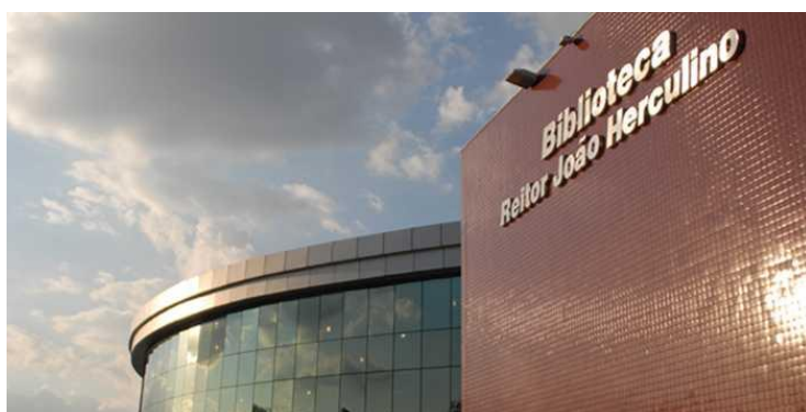
Figura 12 –Fachada da Biblioteca Reitor João Herculino
