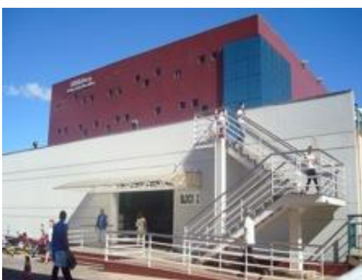
Figura 29 – Acesso a biblioteca pelo lado norte
