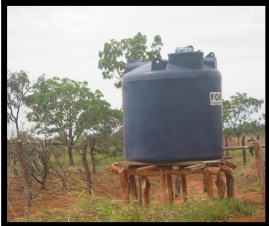
Foto 1- Caixa suspensa para armazenamento de água (Moisés Coelho dos Santos 2013).
