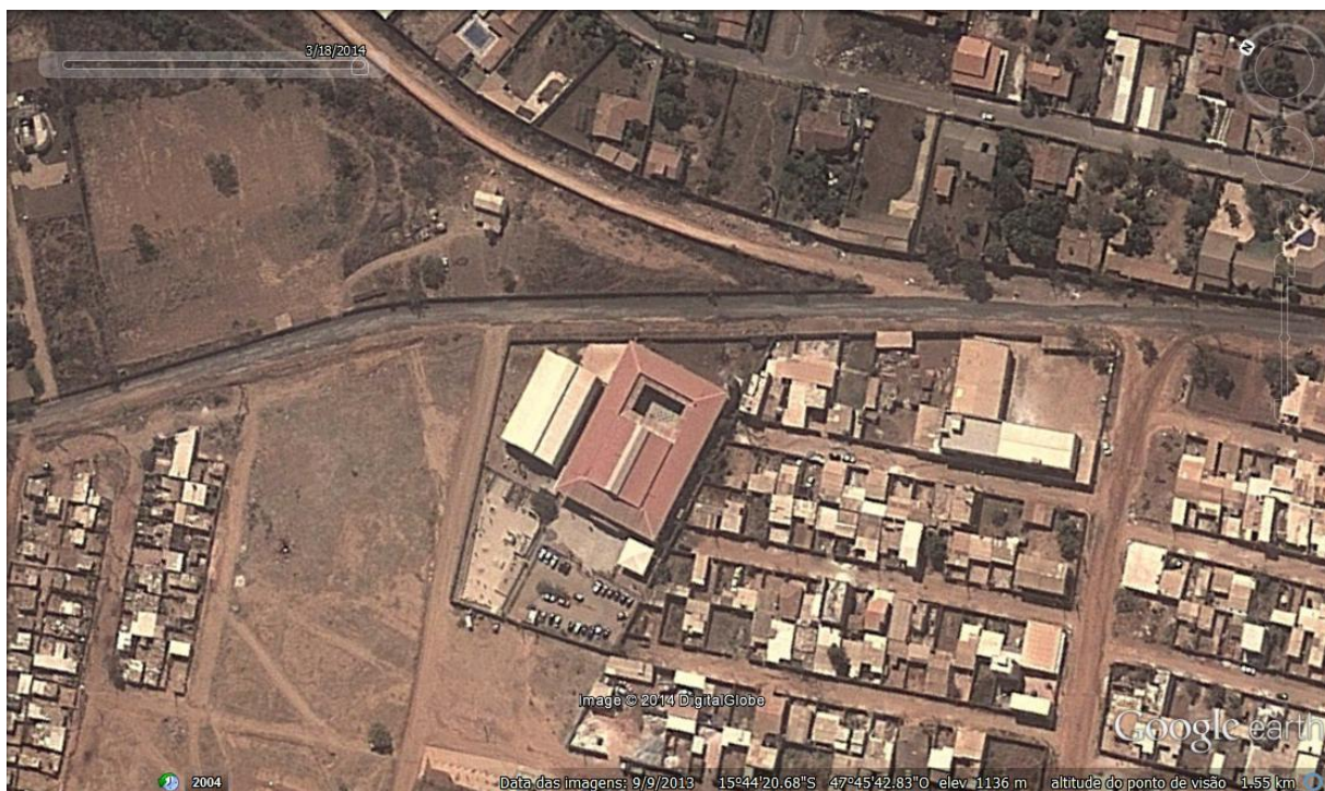
Figura 1 – Centro de Ensino Fundamental Dra. Zilda Arns.
