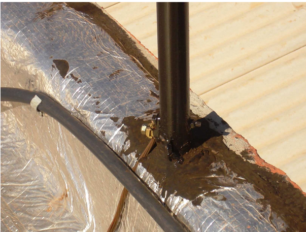
Figura A31: Aterramento Massa Metálica
