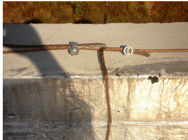
Figura A27: Conexão Malha Aterramento
