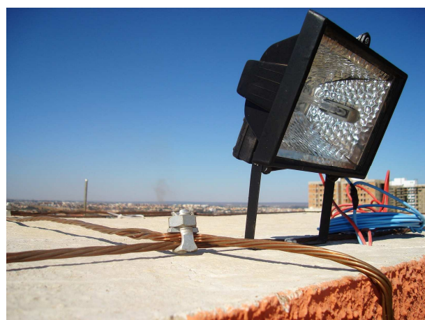
Figura A29: Conexão Malha Aterramento
