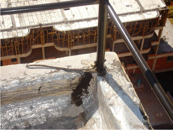
Figura A30: Aterramento Massa Metálica
