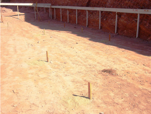
Figura A13: Estaqueamento do terreno
