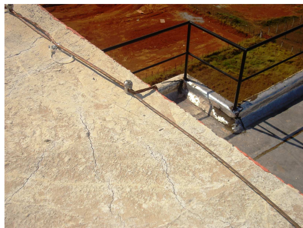
Figura A28: Conexão Malha Aterramento
