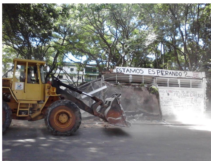
Imagem 7: demolição do edifício okupado (19/03/2014) Fonte: página do facebook da Bicletaria
