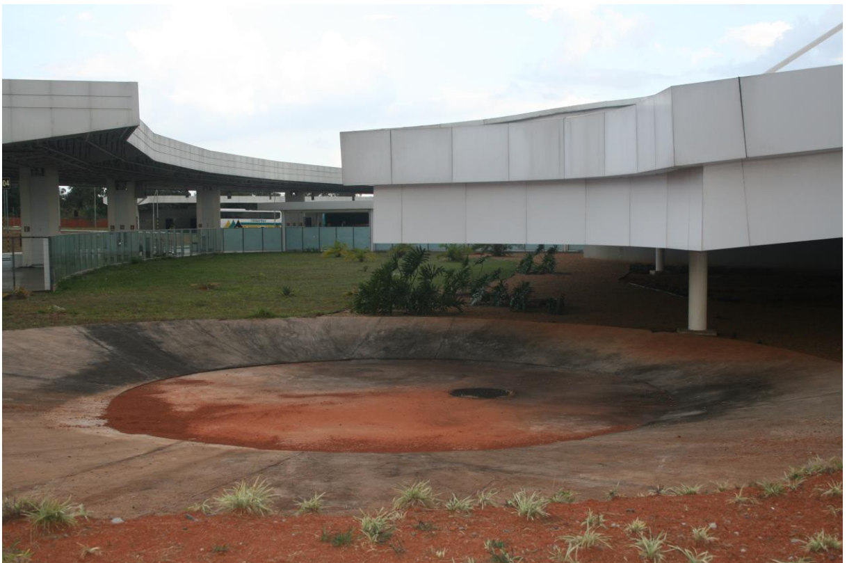
Figura 13: Coletor de Água de Chuva 2. Fonte: Acervo Pessoal.
