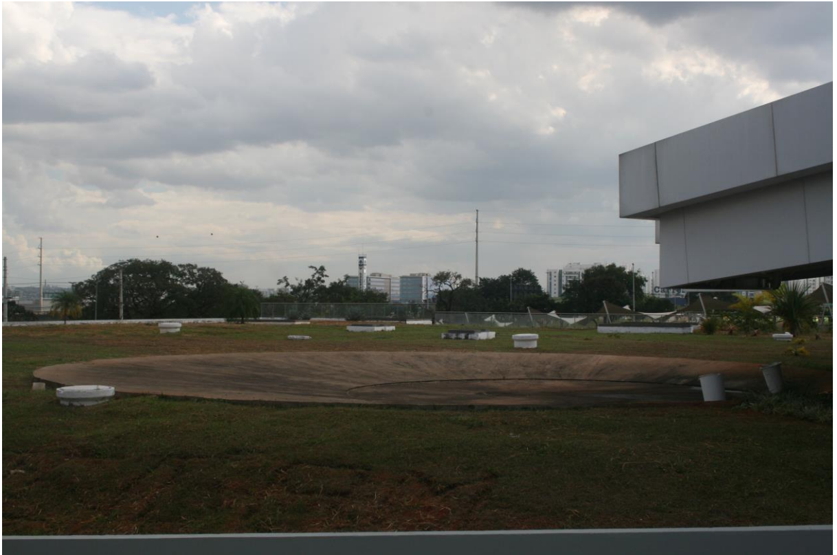
Figura 12: Coletor de Água de Chuva 1. Fonte: Acervo Pessoal.
