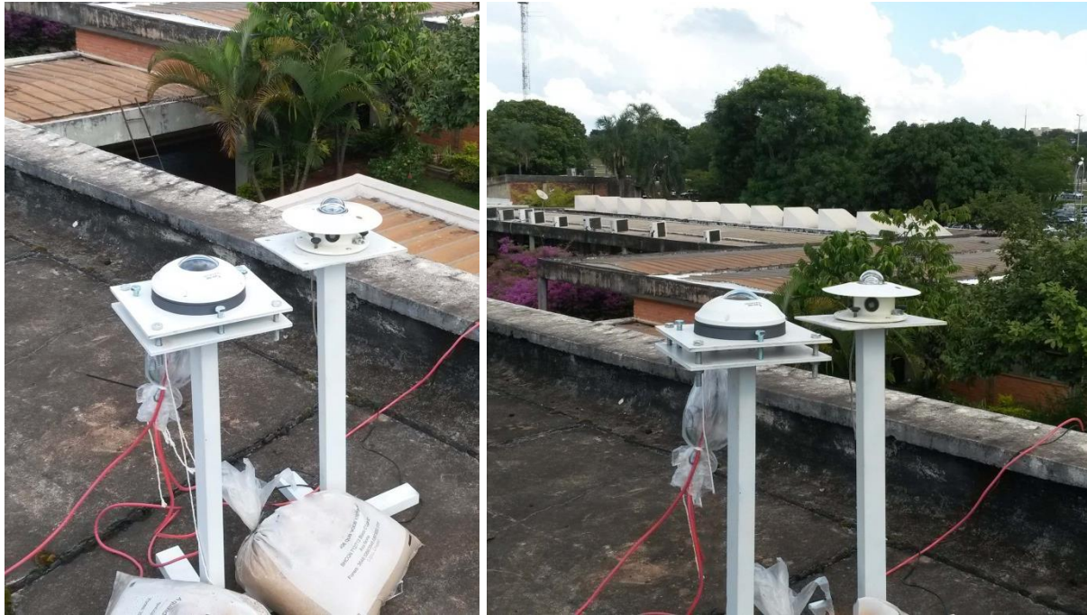
Figura 18: Instalação da Câmera e Piranômetro na cobertura da Faculdade de Tecnologia - UnB
