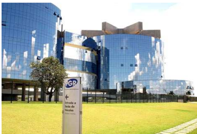
Figura 3.3. Fachada de vidro - PGR.
