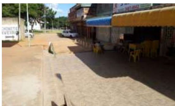
Excesso de desníveis
