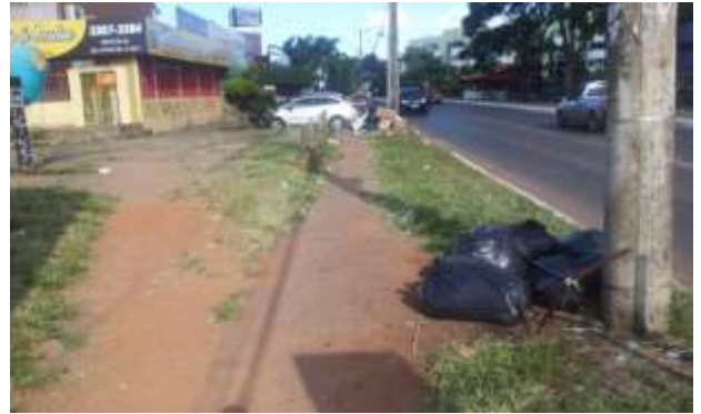
Falta de infraestrutura
