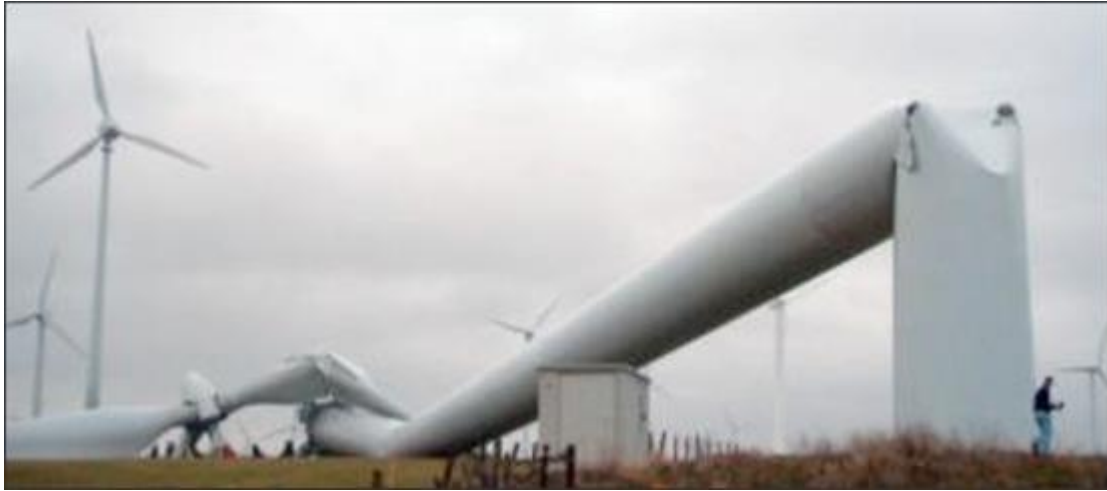
Figura 1.2. Colapso da torre de um aerogerador ( http://salemwind.wordpress.com/health-and-safety/ , acessado em 01/12/2013).
