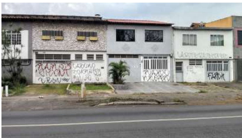
Figura 6 – Pixação feita com spray em residências na W3 sul
