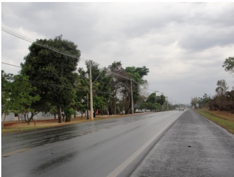
Figura 6: Estrada Parque Vargem Bonita (EPVB) na altura da Quadra 14: é a única via interna dotada de acostamentos laterais; é também a que se encontra em melhor estado de conservação. Fonte: acervo próprio.
