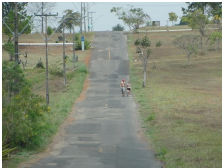
Figura 18 (Quadra 24): a presença das faixas verdes defronte aos terrenos oculta, em visão perspectiva, a presença das construções. Isso ocorre em todas as quadras do Park Way . Fonte: acervo próprio.
