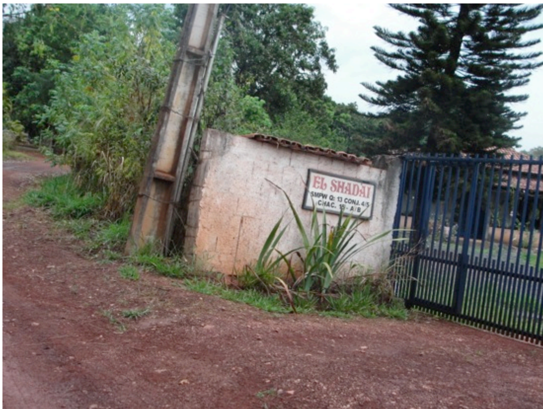
Figura 30: Entrada de chácara pertencente à Granja do Ipê. Observamos o uso irregular de endereço do Park Way . Fonte: acervo próprio.
