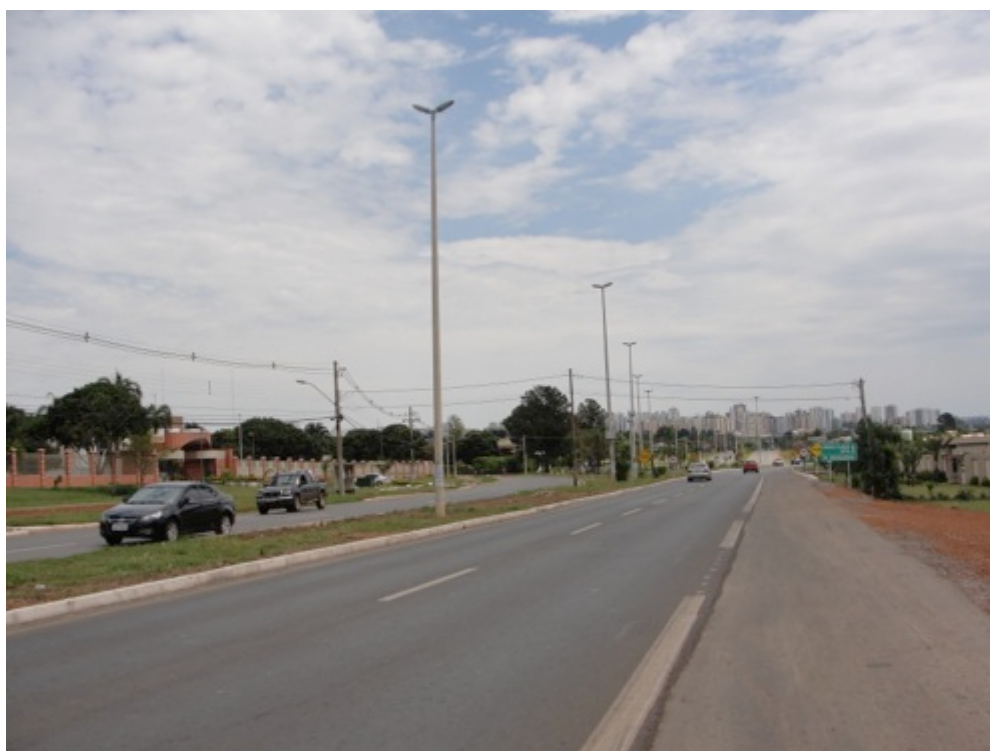
Figura 39 (Quadra 4): estrada EPVP recentemente duplicada para comportar o grande fluxo de veículos que transitam para o Setor Habitacional Arniqueiras e Águas Claras. Fonte: acervo próprio.
