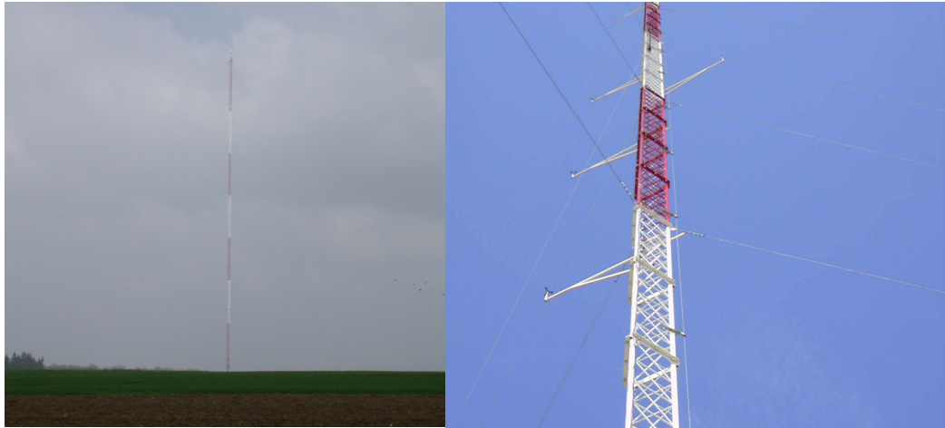
Figura 3. Torres de medição eólica. (a) visão geral da estação meteorológica de uma torre com 69m de altura (b) visão detalhada da parte superior da torre. Fonte: Compagnie du Vent [11]
