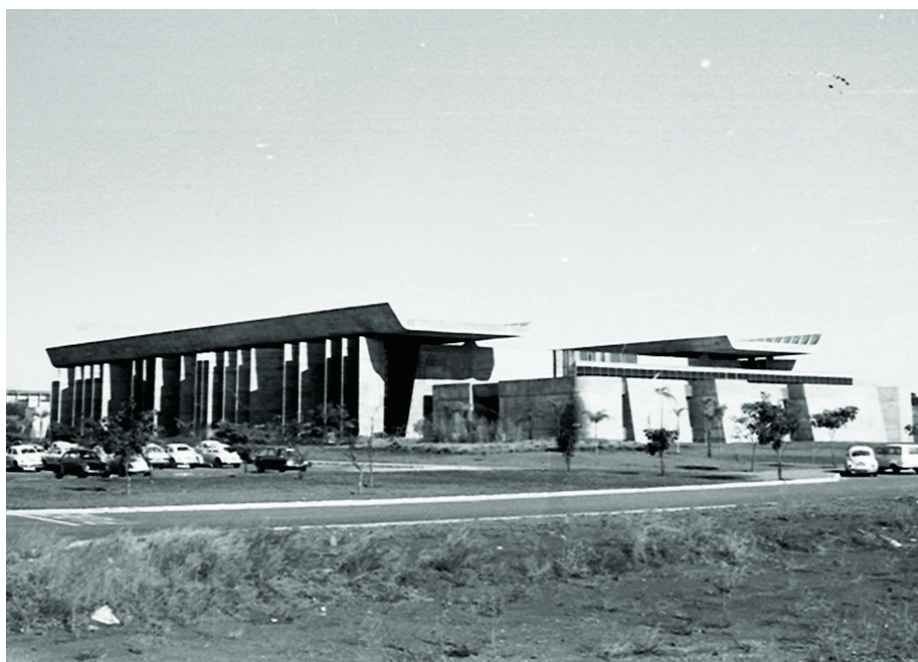
Figura 2: Vista traseira da Biblioteca Central após sua construção.
