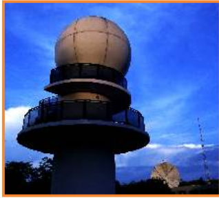
Antena de recepção de dados do satélite Terra-Acqua – Cuiabá (MT)
