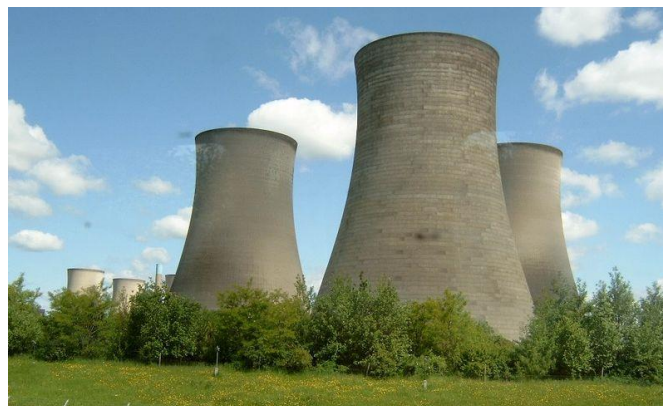
Figura 2.11 - Exemplo de torre de tiragem natural ou hiperbólica (Fonte: http://en.academic.ru/dic.nsf/enwiki/392003 ).
