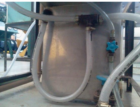
Figura 5.26 - Detalhe do tanque coletor de água após troca das mangueiras (foto tirada pelo autor).
