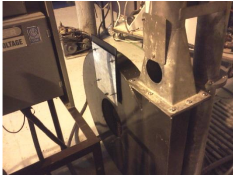
Figura 100 – Placas de orifício
