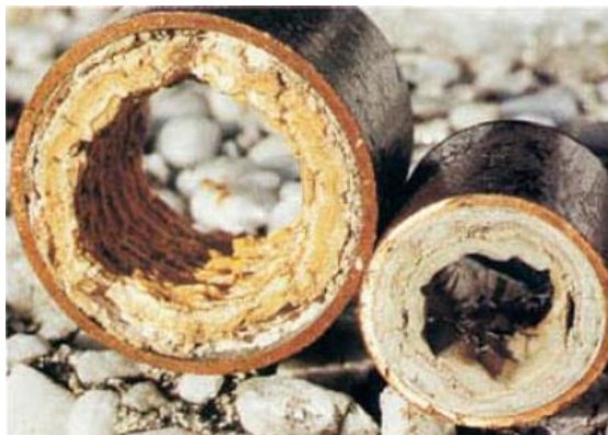
Figura 2.27 - Incrustações de carbonato de cálcio (Fonte: Trovati, Joubert, Tratamento de água de resfriamento, Araraquara-SP, Página 28, 2004).
