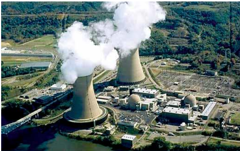
Figura 2.1 - Duas Torres de Resfriamento de tiragem natural da Estação de Energia Beaver Valley localizadas no rio Ohio em Shippingport, Pensilvânia (Fonte: http://www.ecology.com/2012/06/05/water-cooled-power-plants-warming-climate/ , Credit: NRC/First Entergy).
