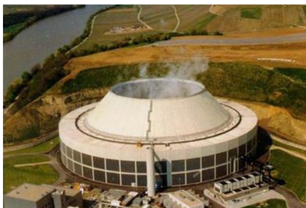
Figura 2.6 - Torre híbrida (seca e úmida) com tiragem mecânica induzida e forçada (Fonte: http://vettortorres.com.br/vettor/Home/Historia ).
