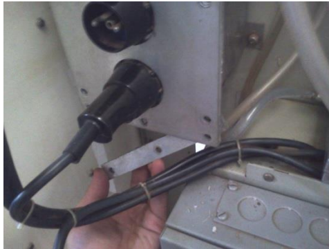
Figura 5.17 - Desmonte da caixa de resistências (foto tirada pelo autor).
