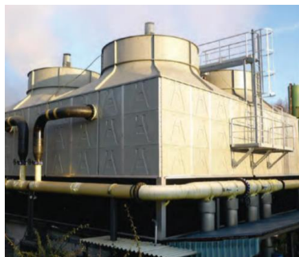
Figura 2.16 – Torre de tiragem mecânica induzida (Fonte: http://spxcooling.com/pdf/a4_CP-10.pdf ).
