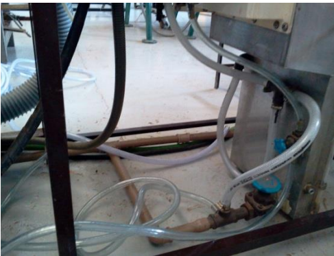
Figura 5.25 - Parte inferior da bancada após a troca das mangueiras (foto tirada pelo autor).
