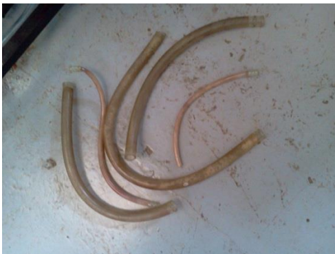
Figura 5.23 - Mangueiras velhas e comprometidas (foto tirada pelo autor).
