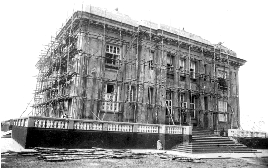
Foto 7 - Palácio Rio Branco Durante obras de reforma no governo de José Guiomard Santos Fonte: Acervo Digital do Departamento de Patrimônio Histórico – FEM
