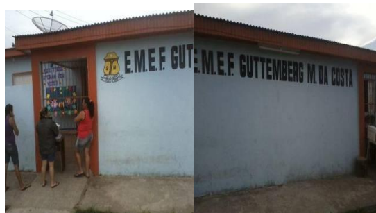
Figura 10: Faixada da escola Guttemberg M. da Costa.
