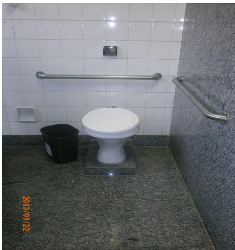
Figura 22. Cabine com vaso sanitário do banheiro acessível.
