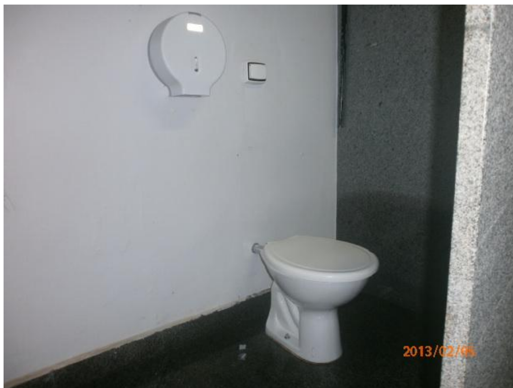
Figura 30. Cabine destinada aos deficientes.
