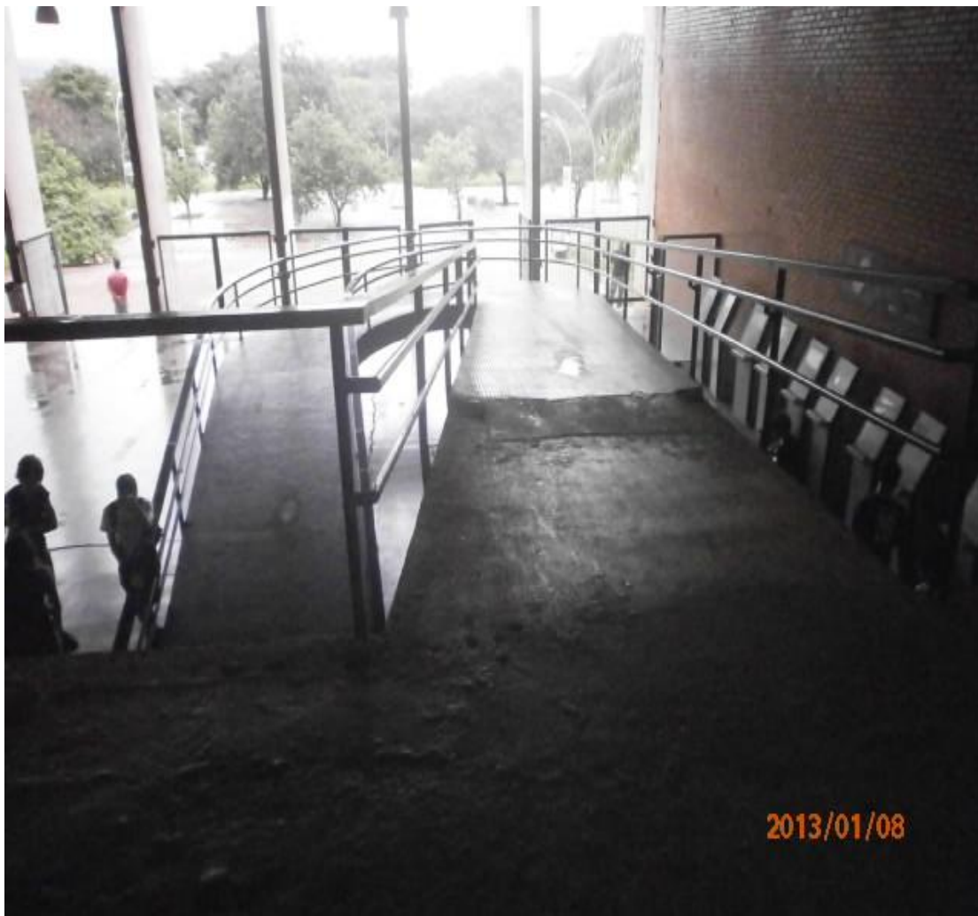
Figura 8. Rampa de acesso entre o térreo e o 1º pavimento
