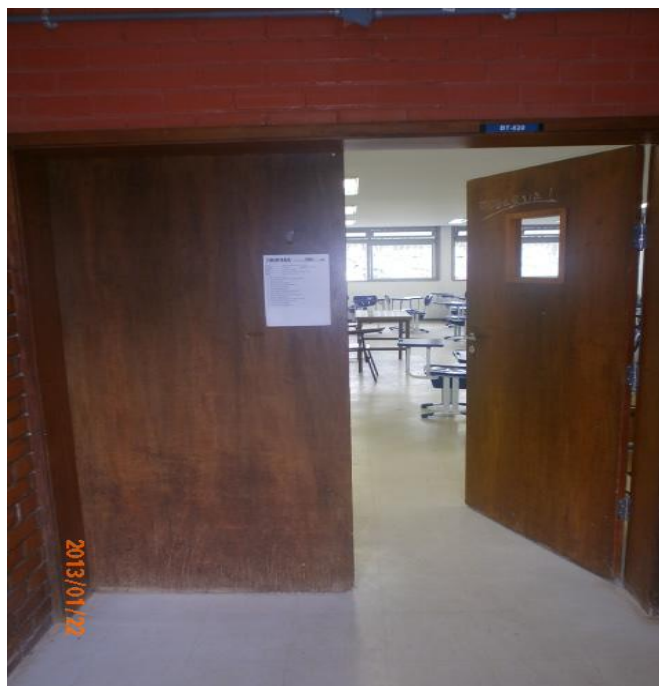
Figura 14. Porta de entrada com duas aberturas.
