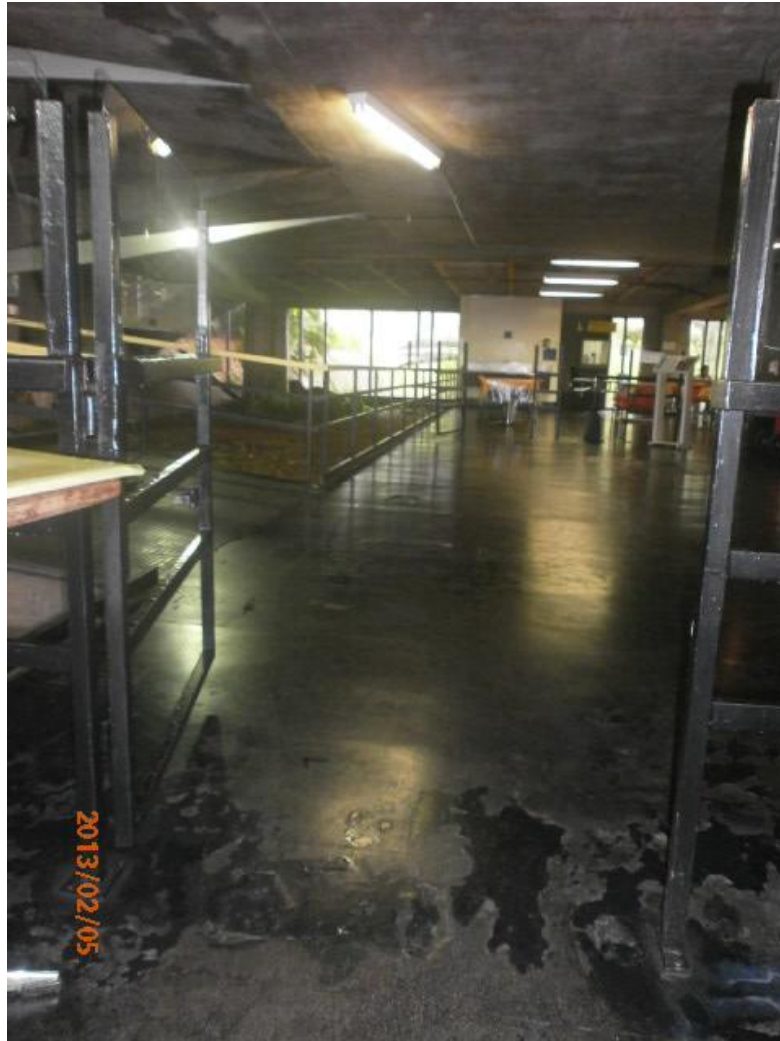
Figura 31. Abertura de acesso ao refeitório.
