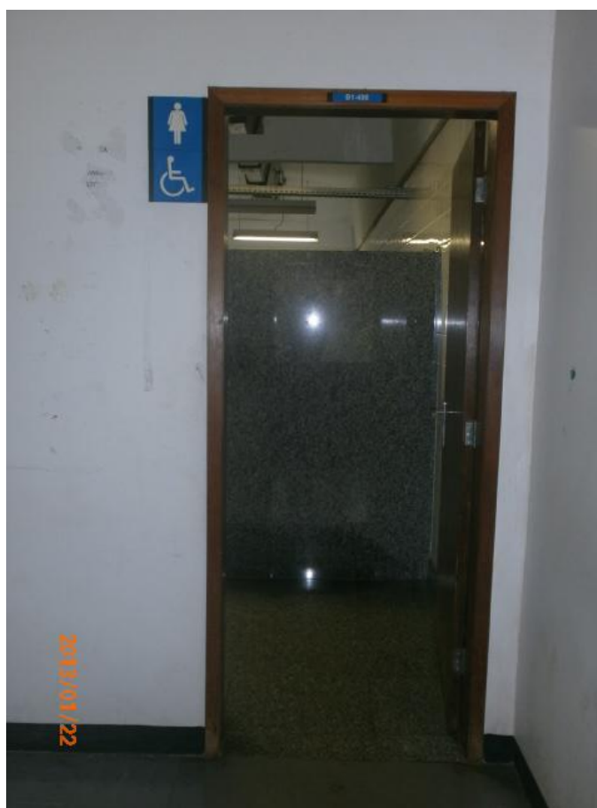
Figura18. Porta principal de acesso ao banheiro.
