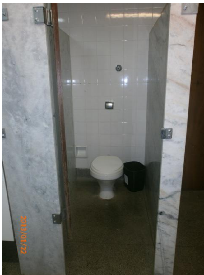
Figura 20. Cabine com vaso sanitário do banheiro “comum”.
