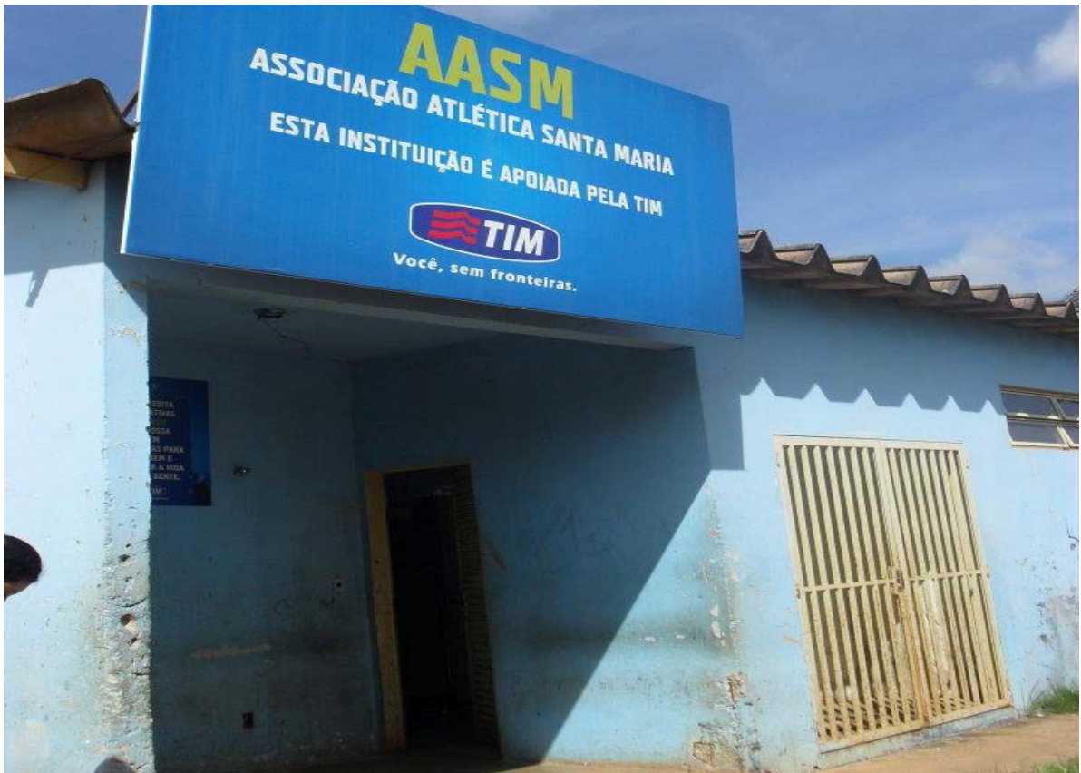
Associação Atlética de Santa Maria antes de reformada e revitalizada.
