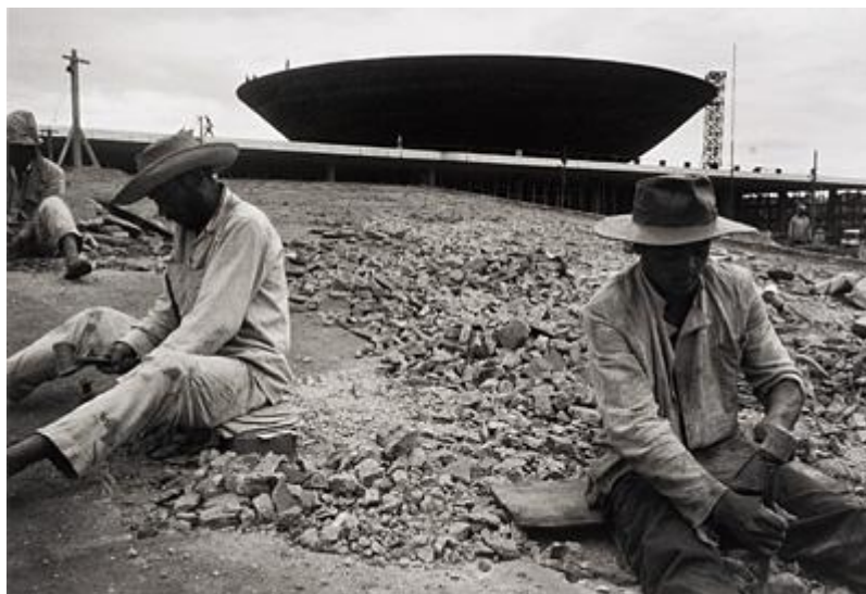
Figura 10- Os Trabalhadores da Nova Capital
