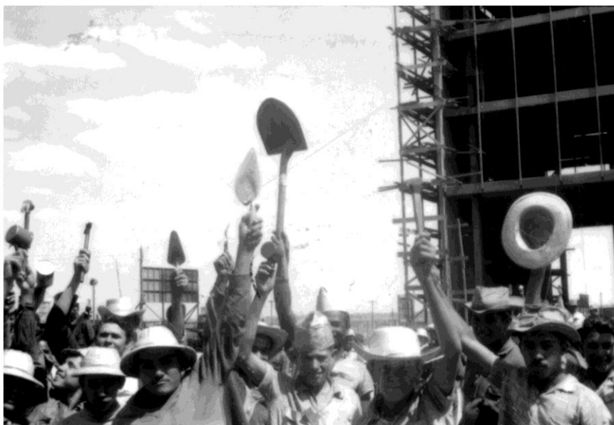
ARQUIVO PÚBLICO DO DF NOV.D.04.04.C.04 N° 3294 CONTEÚDO: OPERÁRIOS DE OBRAS, NA ESPLANADA DOS MINISTÉRIOS LOCAL: BRASÍLIA-DF - DATA: [1957-19560] AUTOR: NÃO IDENTIFICADO
