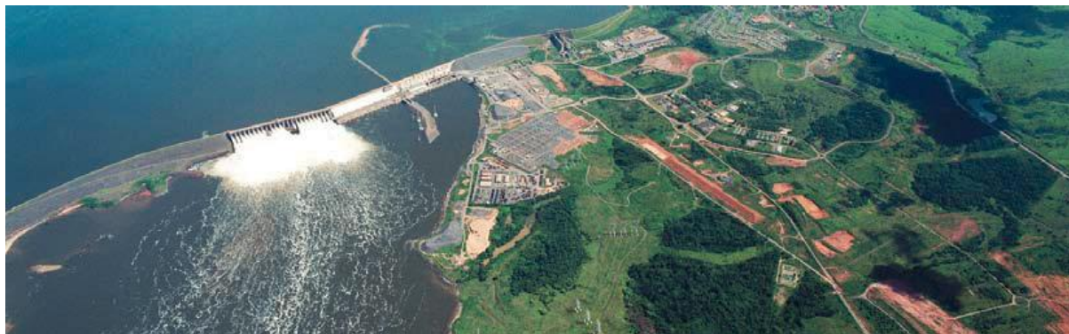
Figura 3 – Usina Hidrelétrica de Tucuruí (Fonte: www.interconnect.com.br )
