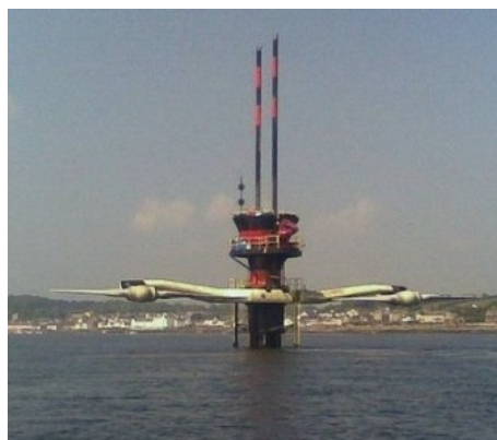
Figura 1.1: Instalação Hidrocínética SeaGen . Composta de duas turbinas com total de 1,2 MWh instalada para aproveitamento de correntes marítimas na Irlanda do Norte. (Jul. 2008)©.
