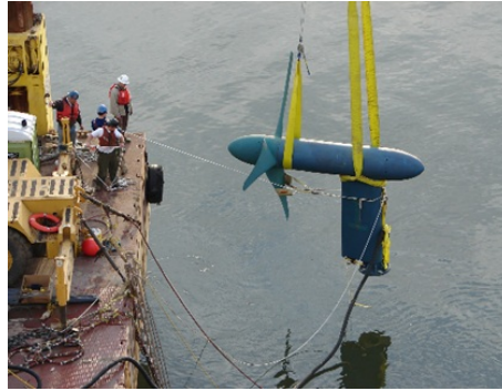
Figura 1.2: Turbina hidrocínética da Verdant Power Inc. Hidrocínética de 100 kWh sendo instalada no East River em New York . (Dez. 2006).
