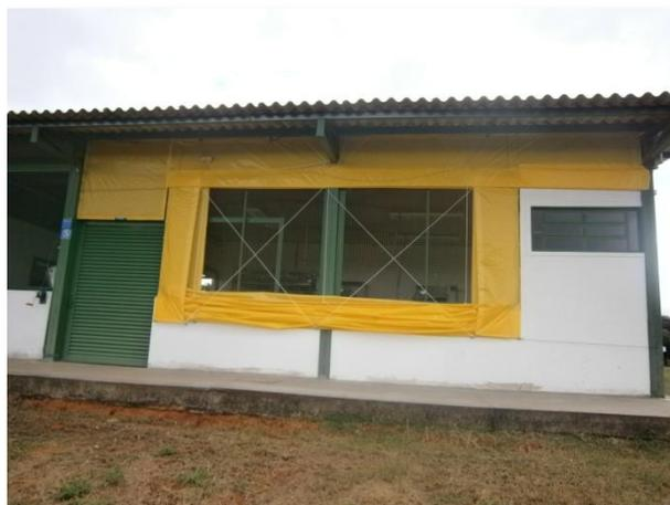
**Figura 1.** Galpão experimental localizado na fazenda Água Limpa – UnB. Representação do sistema de ventilação por cortinas.
