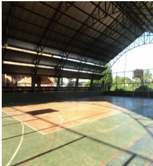
Interior da quadra de esportes ( fig. 05)
