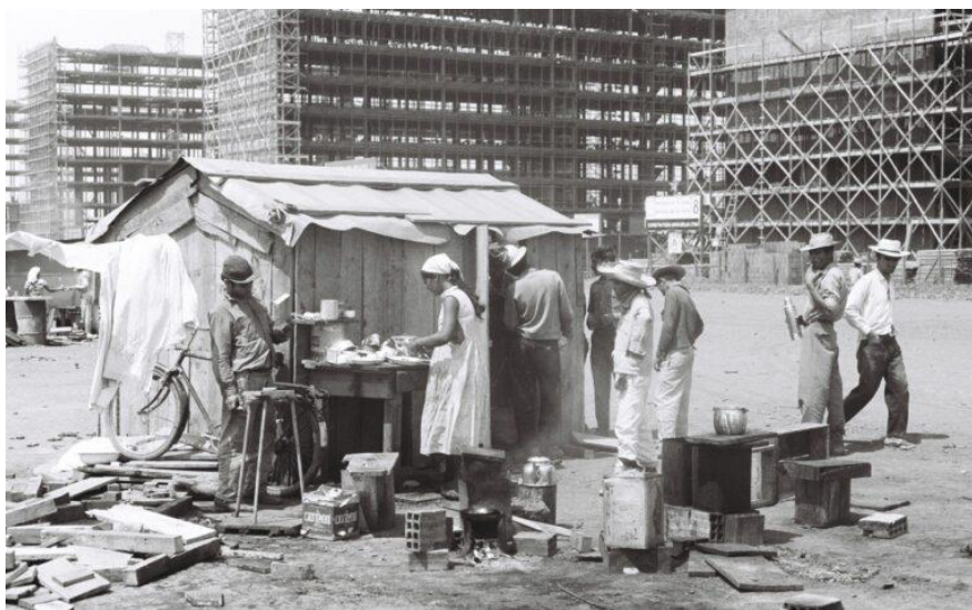
Imagem 30: Candangos em canteiro de obras na Esplanada.
