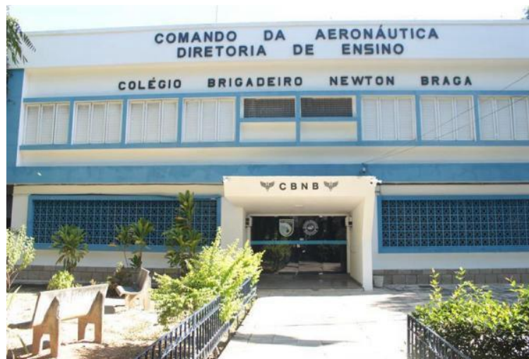
Figura 2 - Fachada do Colégio Brigadeiro Newton Braga
