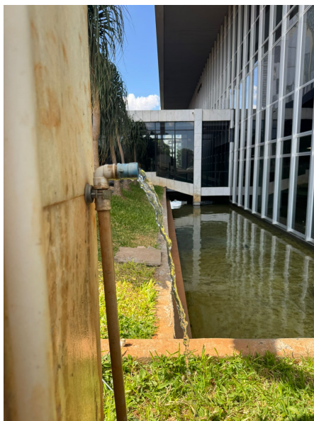
Figura 17: cavalete externo aberto por um minuto para renovação da água.
