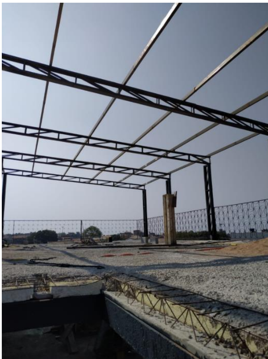
Figura 4.1 Estrutura metálica de edificação para construção civil.
