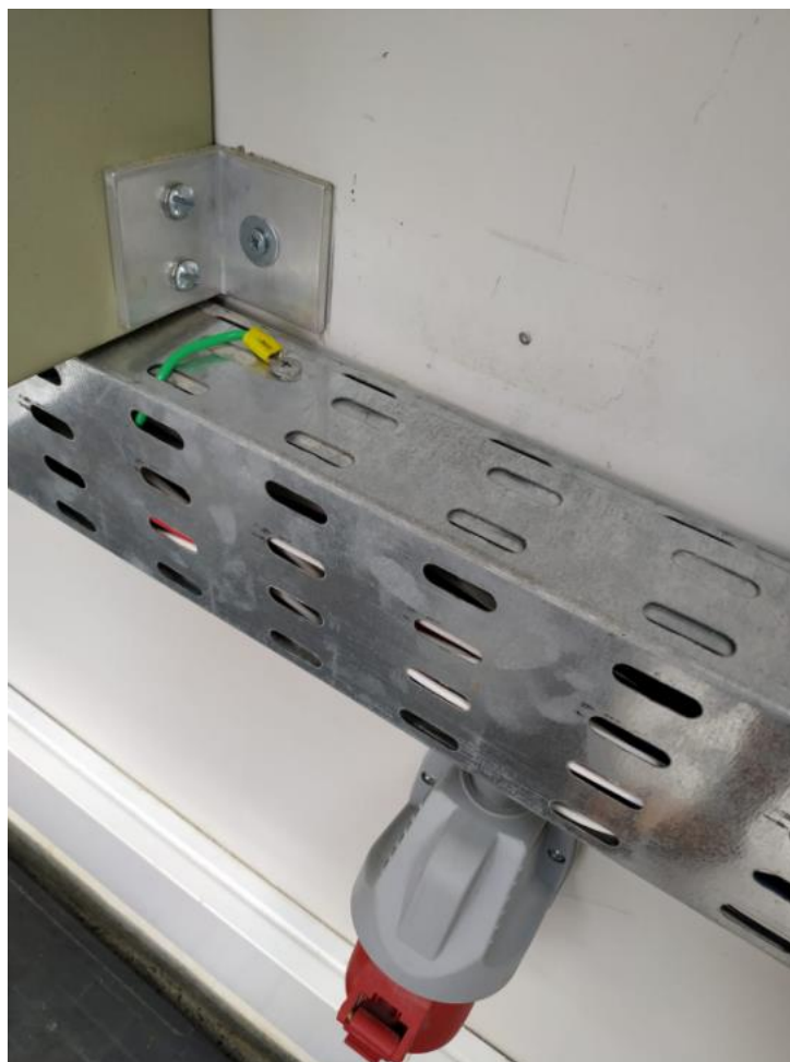
Figura 4.3 Eletrocalha com aterramento no laboratório de instalações elétricas – UnB.
