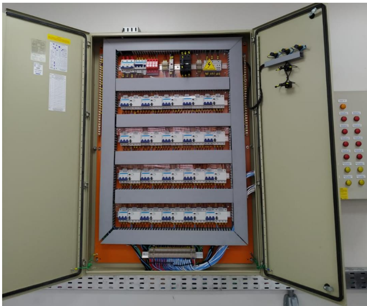
Figura 4.4 Quadro geral de distribuição com aterramento nas duas portas.
