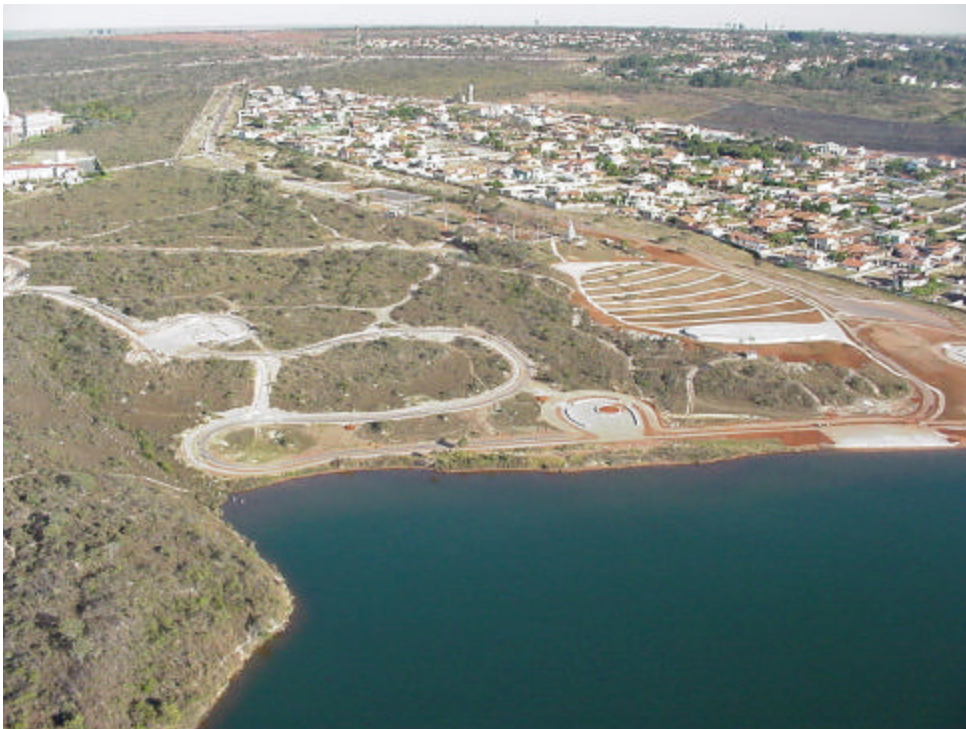
Limites do Parque e do Condomínio Villages Alvorada
