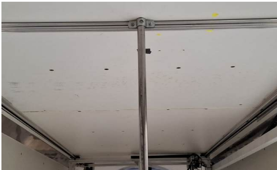
Figura 3.11 – Fixação da parte superior da haste
