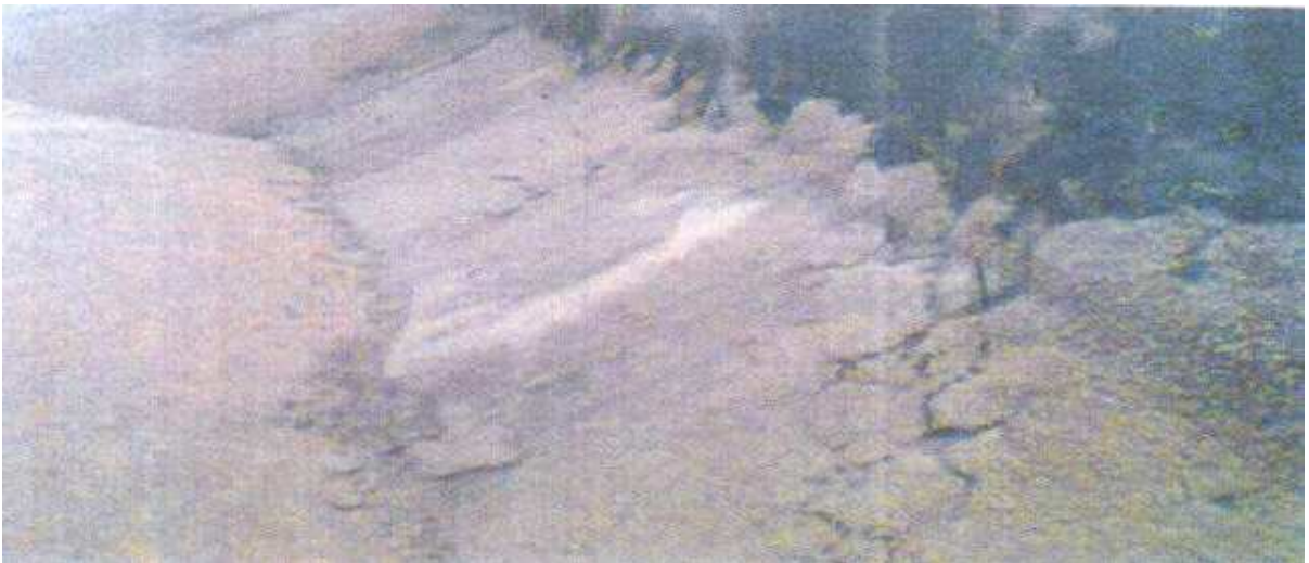
Figura 5: Demonstração de uma camada de aproximadamente 10cm de produtos deteriorados e grudados causando infiltrações nas paredes. Fonte: Conab
