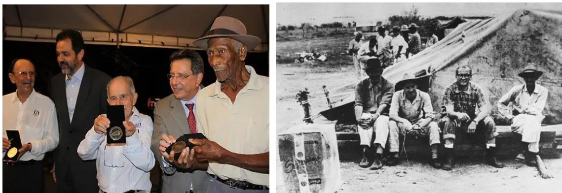
Imagem 4: Sinfrônio Lisboa em obras do Catetinho.
