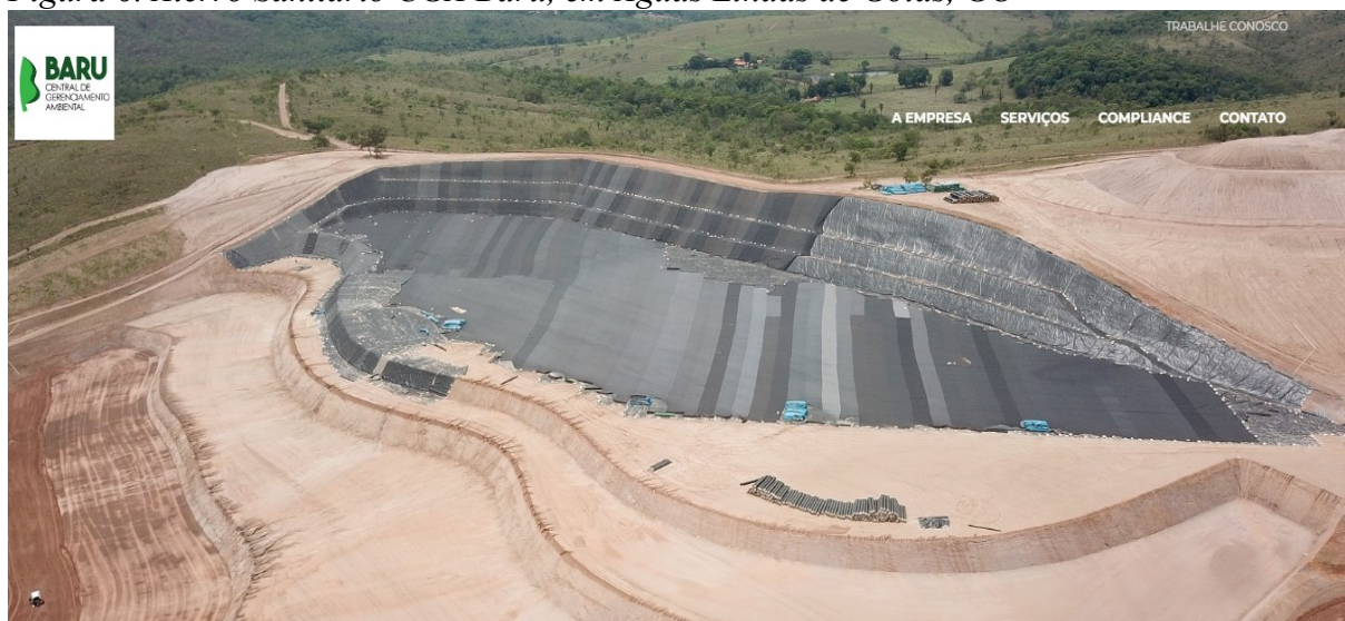
Figura 6. Aterro Sanitário CGA Baru, em Águas Lindas de Goiás, GO
