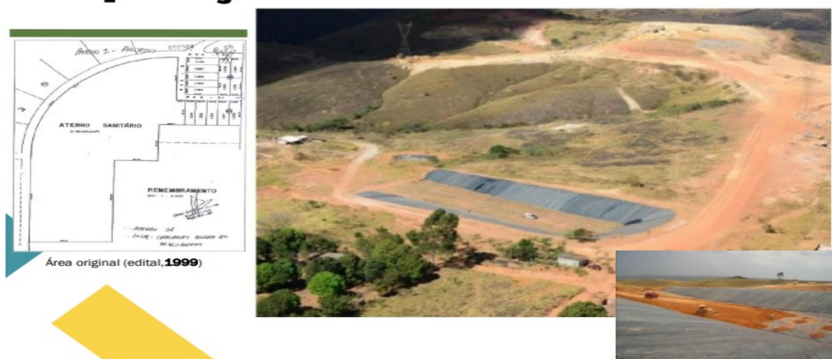
Figura 4. Adequações no Aterro Controlado de Águas Lindas de Goiás no âmbito do TCA.
