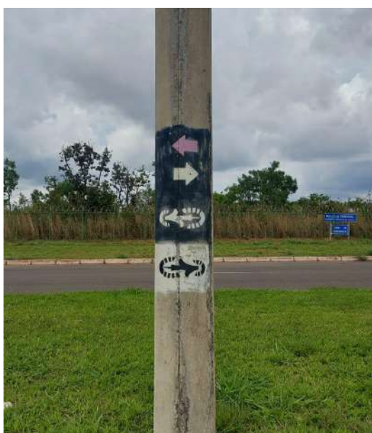
Figura 6: Sinalização de saída, em branco, aplicada em poste de iluminação
