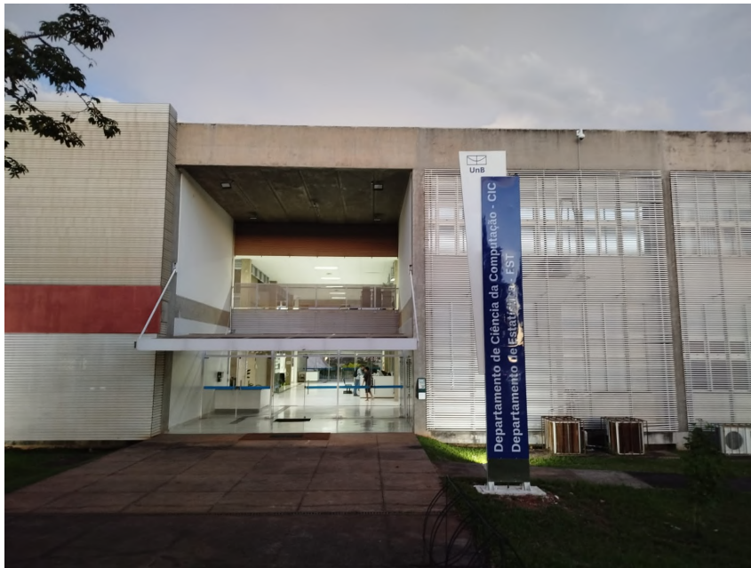
Figura 3.1: Prédio de Ciência da Computação e Estatística - CIC/EST.
