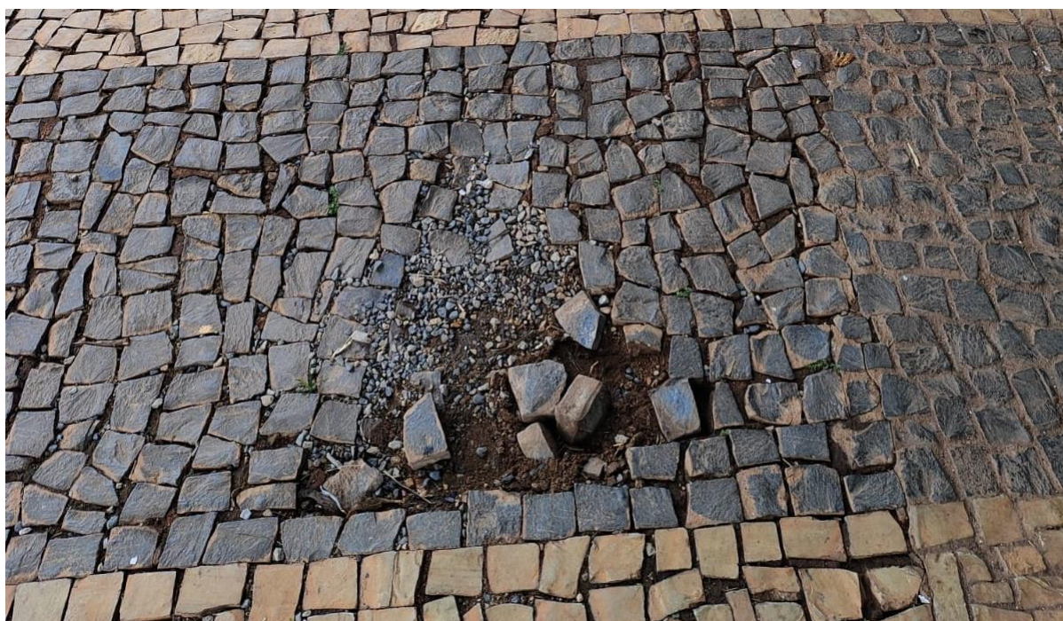
Figura 23: Calçada quebrada no MAF
