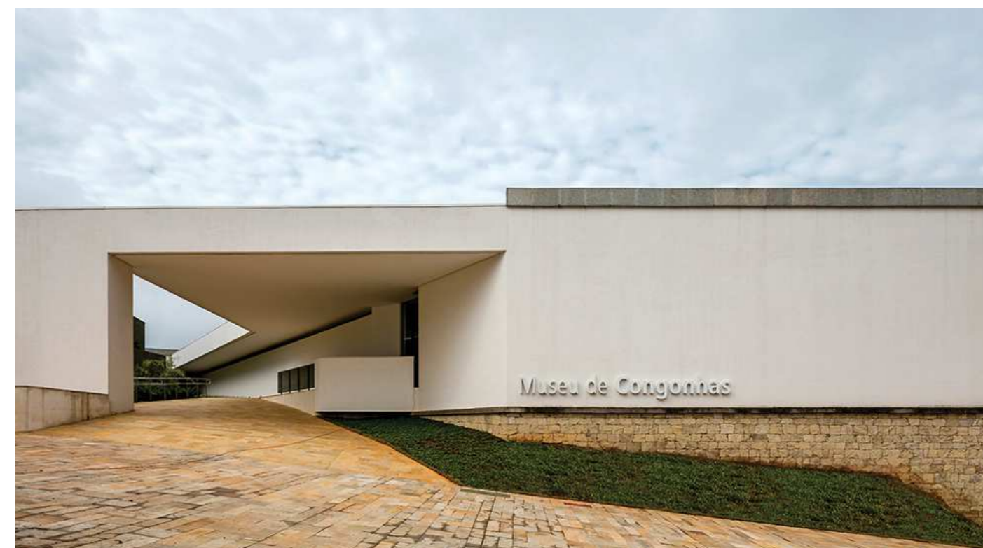
IMAGEM: Museu de Congonhas, Congonhas MG - 2015 Fonte: Archdaily
