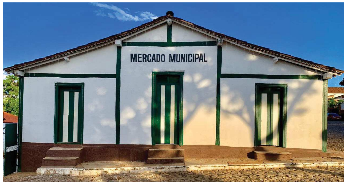
IMAGEM: Mercado Municipal Restaurado, 2019 Fonte: Vergue Imagens
