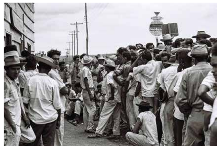
Candangos fazem fila para se cadastrar construção de Brasília. Fonte: Arquivo Público do DF
