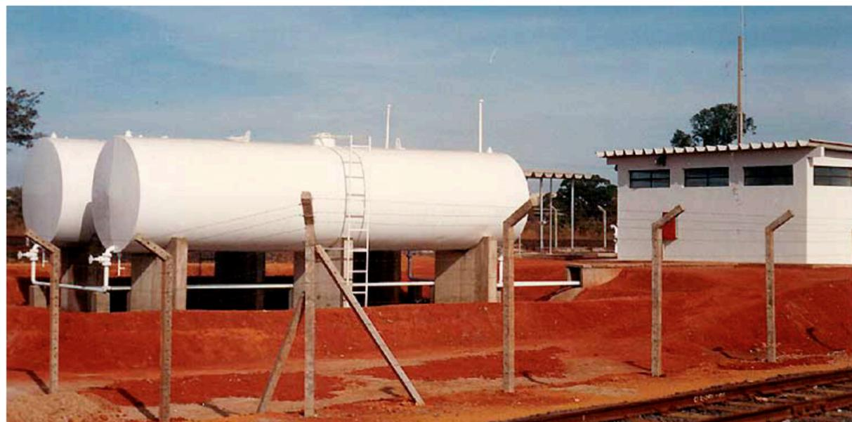
Figura 51 - Local de abastecimento de locomotivas, com montes de terra em volta impedem o combustível de se espalhar em caso de vazamento
