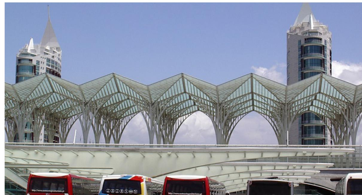
Figura 68 - Estrutura metálica da cobertura
