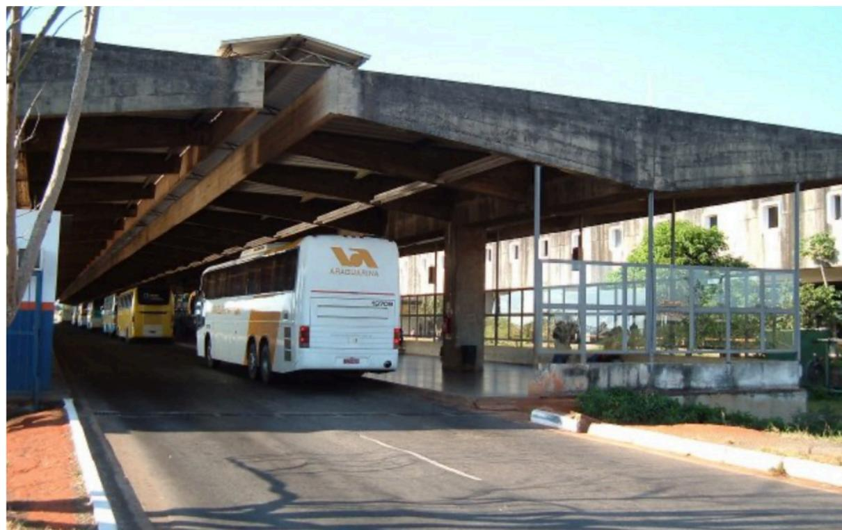
Figura 22 - Plataformas de embarque da estação, originalmente destinadas aos trens, que foram adaptadas para receber os ônibus realocados do subsolo
