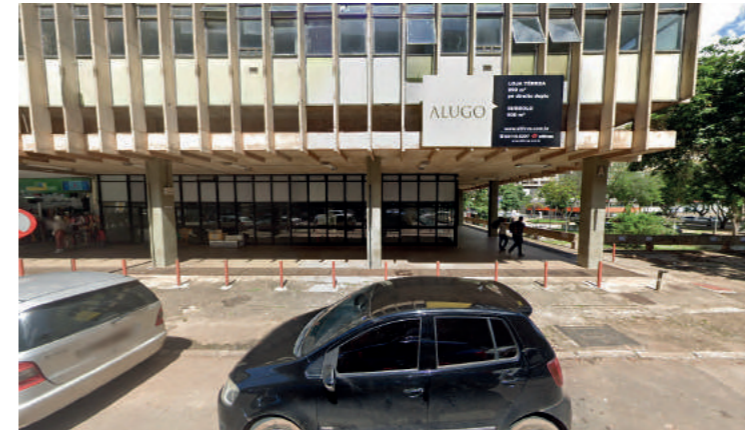
Edifício Dona Angela vista térreo
