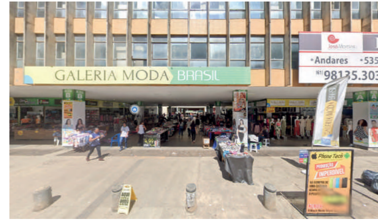
Edifício Oscar Alvarenga vista térreo
