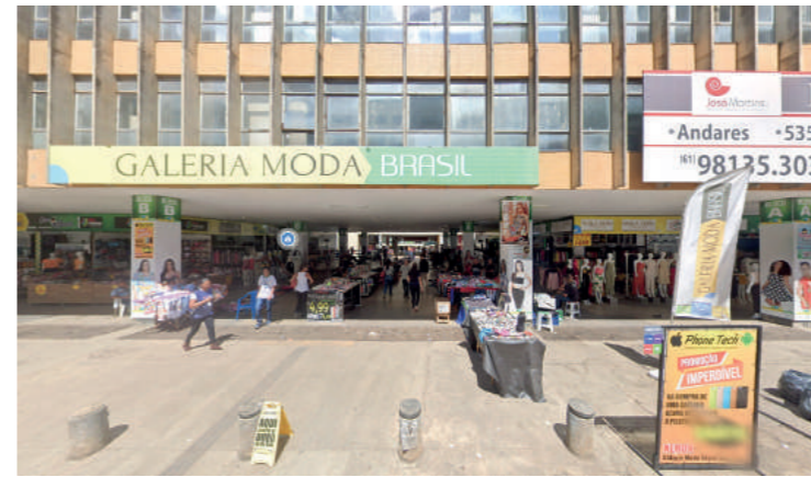
Edifício Oscar Alvarenga vista térreo
