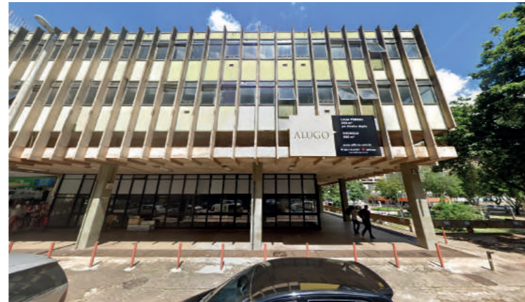
② Edifício Dona Angela vista frontal
