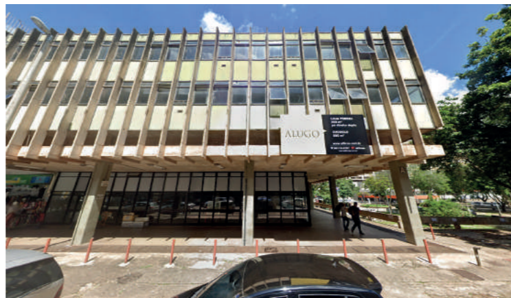
6 Edifício Dona Ângela vista frontal
