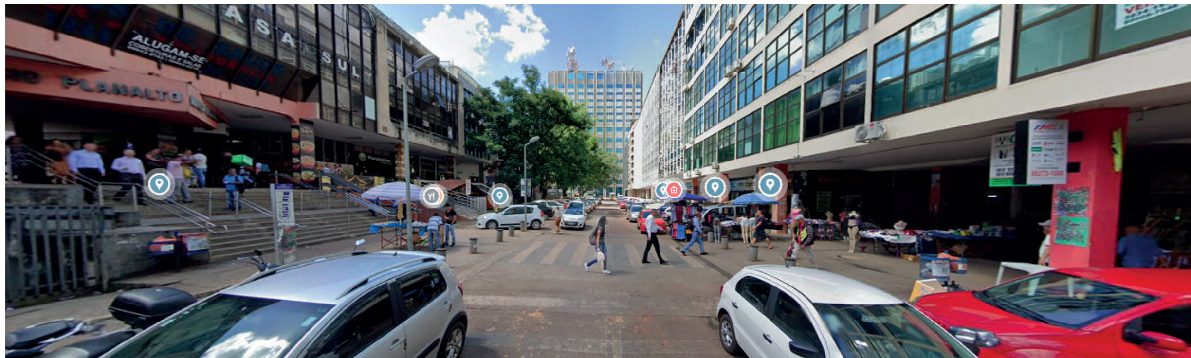
Situação Existente Via Trecho 7 Fonte: StreetView 2020
