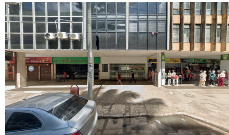
Edifício N. 114 vista térreo
