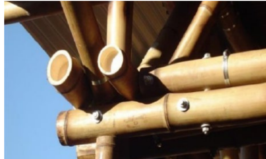
Fig. 17 - Conexão metálica com bambu Fonte: Wu, Y., & Xiao, Y. (2018)
