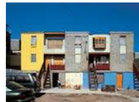
Figura 7. Fachada. Fonte. Archdaily/ELEMENTAL
